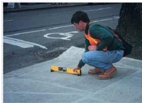
129-р зураг - Налуу хавтангийн налууг тоон хэмжигчээр хэмжиж байна
