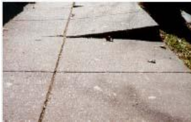
21-р зураг - Модны үндэс түрэн гарснаас замын хавтан овойж төвшингийн өөрчлөлт үүссэн байдал
