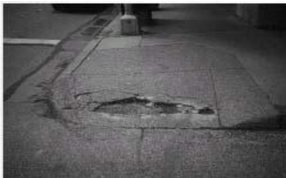
114-р зураг - Явган хүний замд гарсан нүх сүв болон эвдэрсэн бетон нь явган зорчигчийн хөдөлгөөнд бэрхшээл учруулж, аюулгүй зорчиход саад болдгийг харуулав
