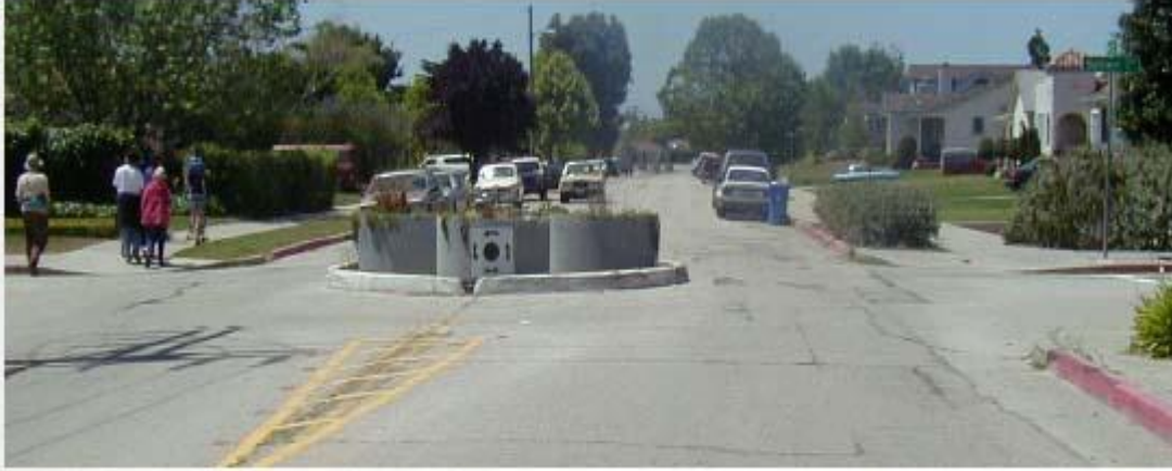
108-р зураг - Орон сууцны хорооллын хөдөлгөөний тойргийг хөдөлгөөний эрчим багатай уулзварт хурдыг хянах босоо хэрэгсэл болгон ашигласан байдал
