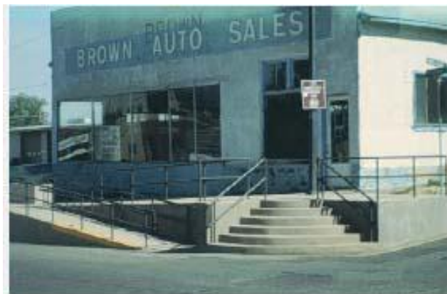
79-р зураг - Өндөр хашлагатай хэсгээс доош буух налуу хавтанг төсөллөхдөө тэргэнцэртэй болон явган зорчигчийн хөдөлгөөнийг хязгаарлахгүй байхад анхаарсан байдал
