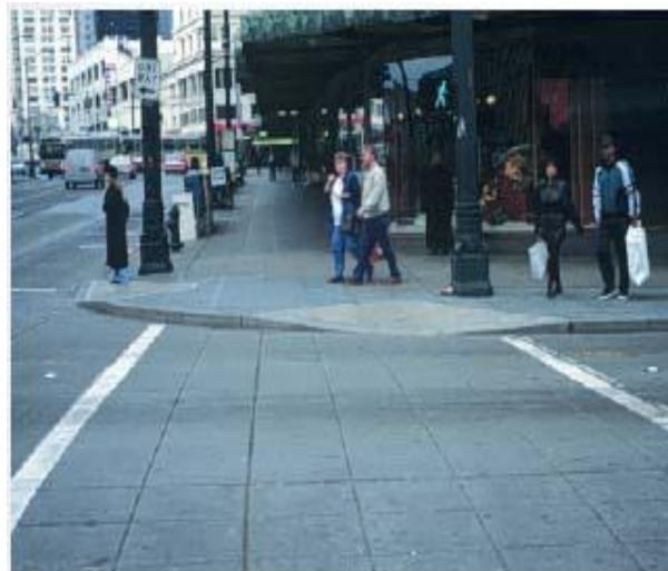
47-р зураг - Налуу хавтан нь хөгжлийн бэрхшээлтэй иргэдийг хөдөлгөөнд чөлөөтэй оролцох боломжийг хангаж төсөллөсөн байдал
