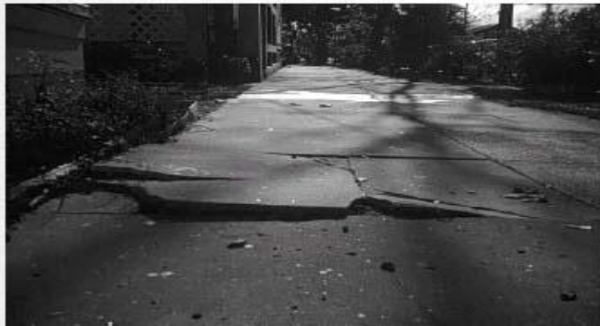
113-р зураг-Явган хүний замын тогтмол арчилгаа нь хучлага овойж түвшингийн өөрчлөлт гарах зэрэг эвдэрлийг засварлах болон түүнээс сэргийлэх боломжийг олгоно
