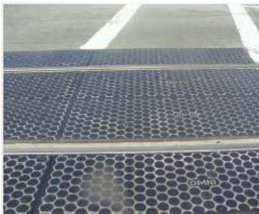
94-р зураг - Төмөр замын гарц дээр асфальтны оронд резинэн материал суурилуулсан байгаа нь түвшингийн өөрчлөлтийг багасгаж, явган хүний хөдөлгөөнийг хөнгөвчилдөг
