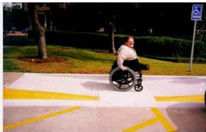
82-р зураг - Зэрэгцээ налуу хавтан нарийн зам дээр тохиромжтой боловч явган зорчигч хөдөлгөөнөө үргэлжлүүлэхдээ налууугийн 2 хэвгийг давах шаардлагатай болж байна.
