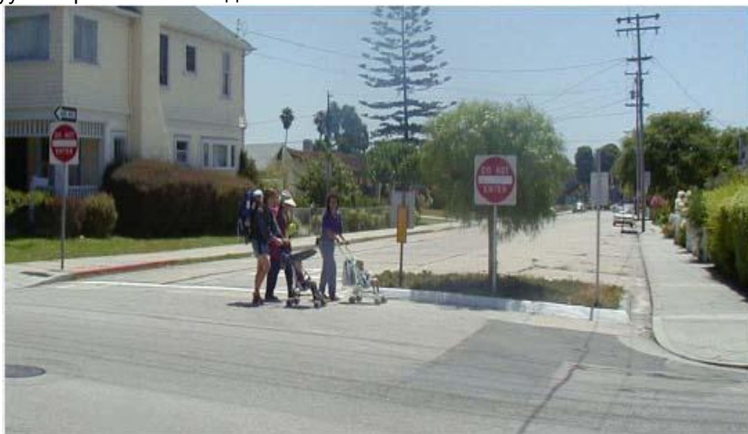
95-р зураг - Уулзварт тавьсан хагас хаалт нь замын хөдөлгөөнийг сааруулах нэг арга бөгөөд автомашины замын хагасыг хааснаар нэг чиглэлийн хөдөлгөөнийг бий болгож, жолооч орон сууцны гудамжийг тойрч гарах нөхцөл бүрдсэн байна
