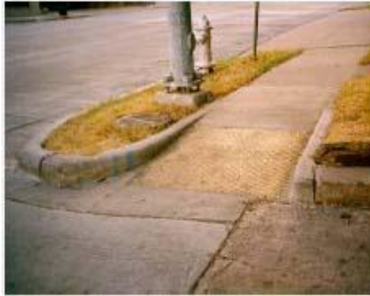
63-р зураг -Налуу хавтангийн доод хэсэгт харааны бэрхшээлтэй иргэдэд зориулан анхааруулах товруутай гадаргуу суурилуулсан байдал
